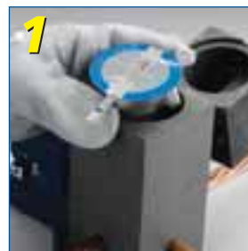
1 Positionner la capsule CADWELD PLUS dans le moule
