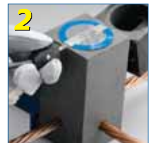
2 Brancher le connecteur sur la languette d'allumage
